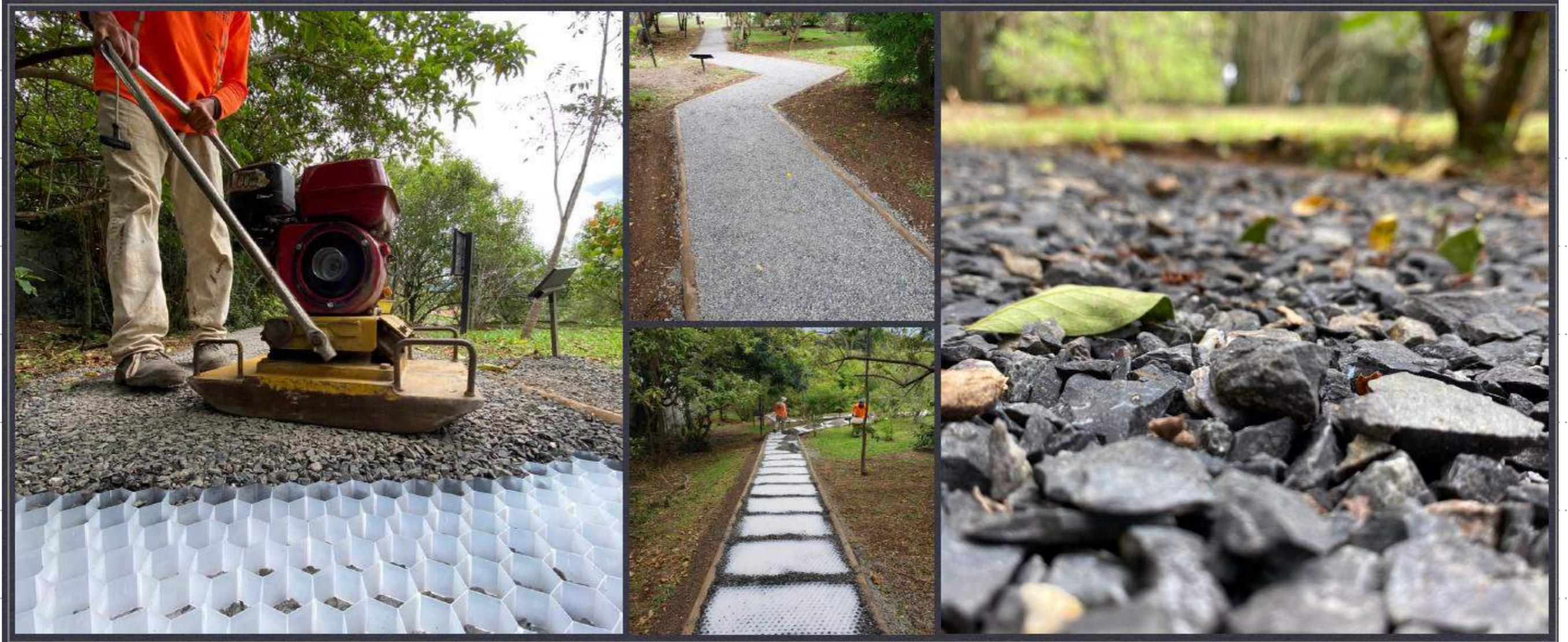
**PARQUE AMBIENTAL** - Asunción de Belén (2020): 604 m<sup>2</sup> pavimento permeable, 55 m<sup>3</sup> de control de escorrentía superficial, infiltración instantánea, evaporación.
