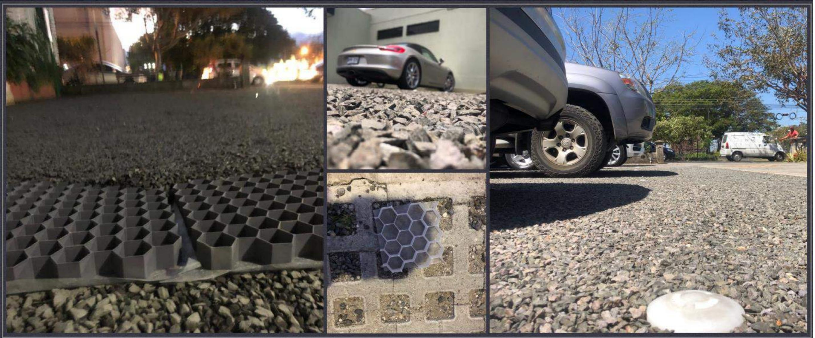
PARQUEO MUNICIPALIDAD BELÉN (2019): 102 m<sup>2</sup> pavimento permeable, 11 m<sup>3</sup> de control de escorrentía superficial, infiltración instantánea, evaporación.
