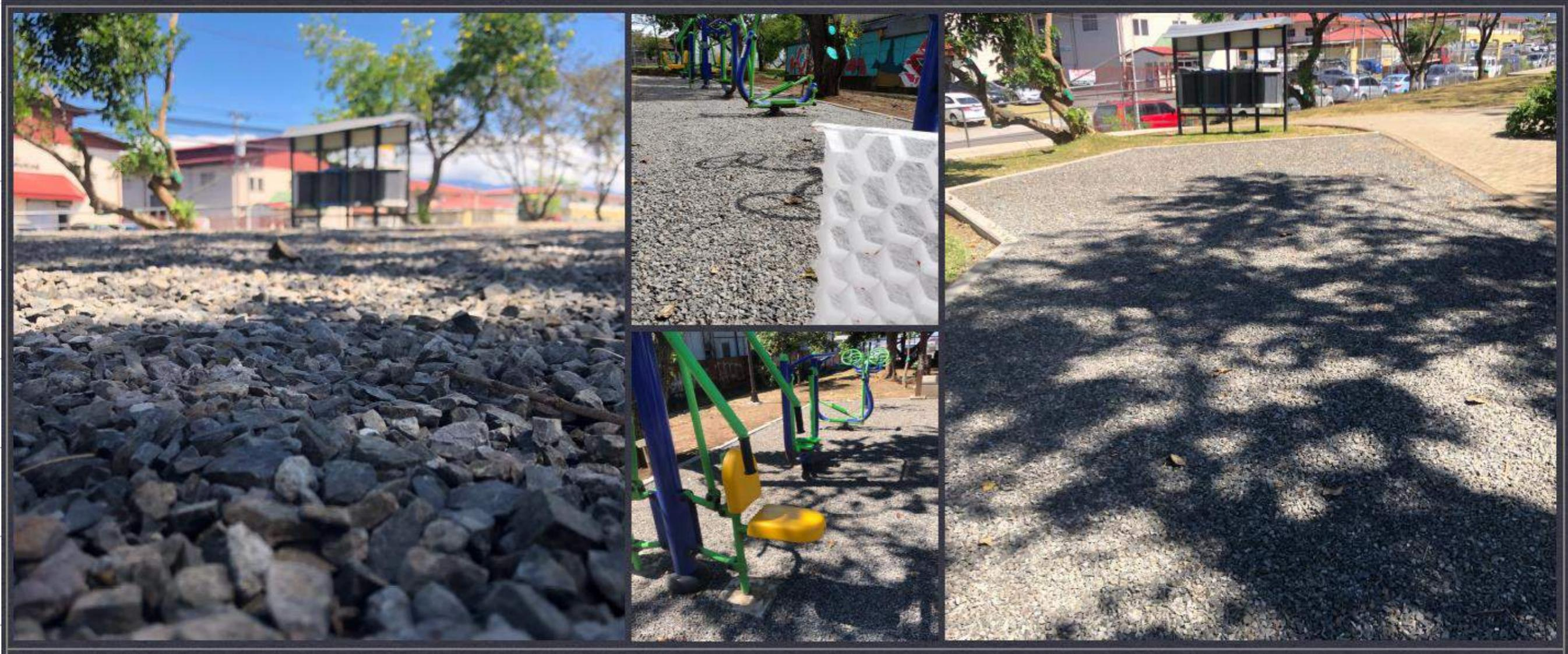
**SKATE PARK** - Asunción de Belén (2019): 155 m<sup>2</sup> pavimento permeable, 17 m<sup>3</sup> de control de escorrentía superficial, infiltración instantánea, evaporación.
