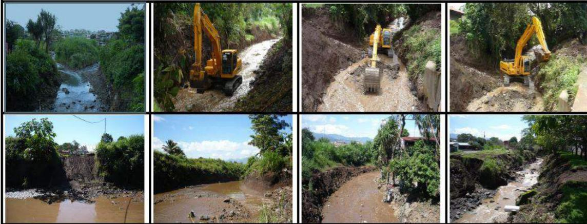
*Ce secteur est précédé d'une zone de rejets d'eaux usées et de dépôts de déchets importante, Par conséquent, le débit dans cette zone est important et les débordements sont fréquents. Les travaux de dragage continuent encore pour tenter de faire transiter le débit liquide arrivant de l'aval et ainsi pour que l'écoulement se fasse de manière plus fluide.*
