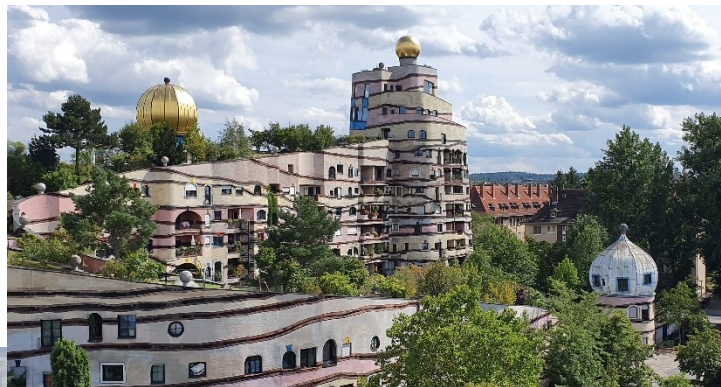
Edificio habitacional “Waldspirale” en Darmstadt, diseñado por el artista austriaco Friedensreich Hundertwasser y construido por la empresa de viviendas Bauverein Darmstadt, cuenta con 105 apartamentos de vivienda.
