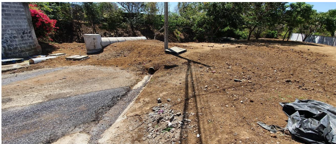
Arriba: Etapa de construcción del prototipo “Área de infiltración de aguas grises”. Abajo: Área de infiltración y sistema de atenuación completados.
