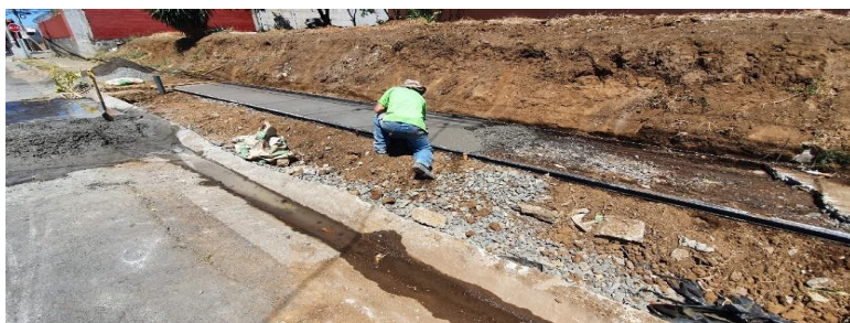
Izquierda: Etapa de construcción del prototipo “Sistema de retención a nivel de calle”. Derecha: Área de retención finalizada colocada en la vía que conecta la Urbanización Siglo XXI con Barrio Los Ángeles.
