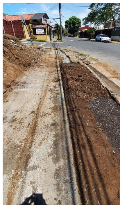
Izquierda: Etapa de construcción del prototipo “Sistema de retención a nivel de calle”. Derecha: Área de retención finalizada colocada en la vía que conecta la Urbanización Siglo XXI con Barrio Los Ángeles.
